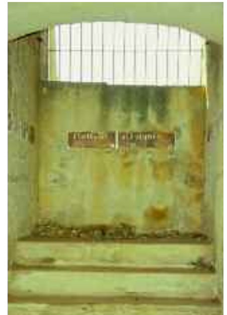
Διάδρομος υπόγειου καταφυγίου στις Ιταλικές στρατιωτικές εγκαταστάσεις στη Σκουμπάρδα.
